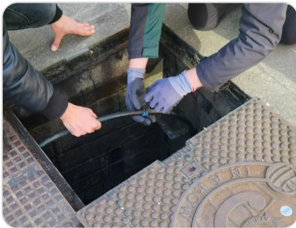
ATTACHING LOC TAGS TO CONDUITS
